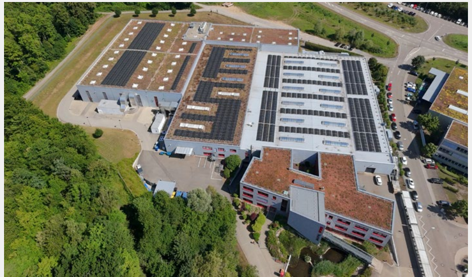
Fast 3.200 Quadratmeter Dachflächen belegt die neue PV-Anlage bei MAPAL in Pforzheim. Bereits zwölf Prozent des gesamten Energiebedarfs des Standorts kann nunmehr durch regenerative Quellen gedeckt werden.
